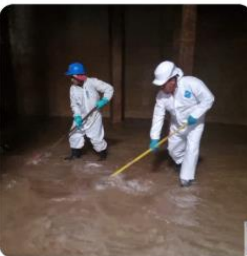
Limpieza y desinfección de las cámaras de reunión y estaciones de bombeo.
