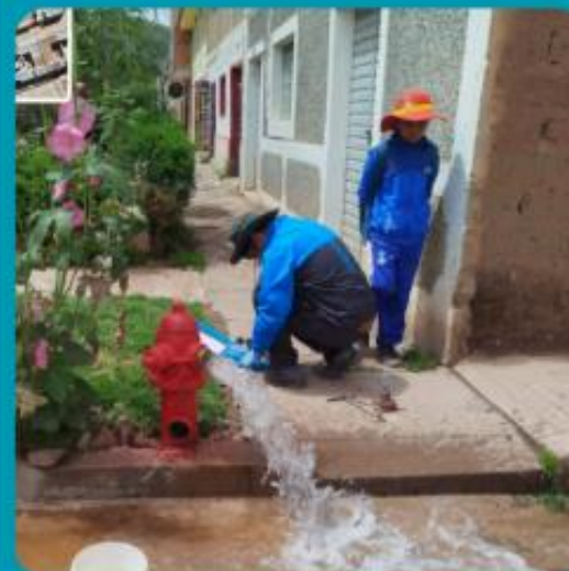
Purga y mantenimiento de las redes de distribución
